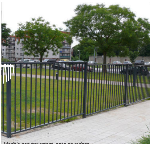
Modèle non traversant, pose en redans
